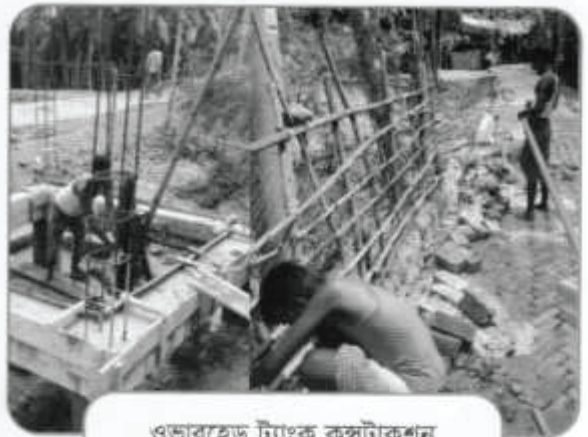
ওভারহেড ট্যাংক কন্সট্রাকশন, পাইপ লাইন স্থাপন
